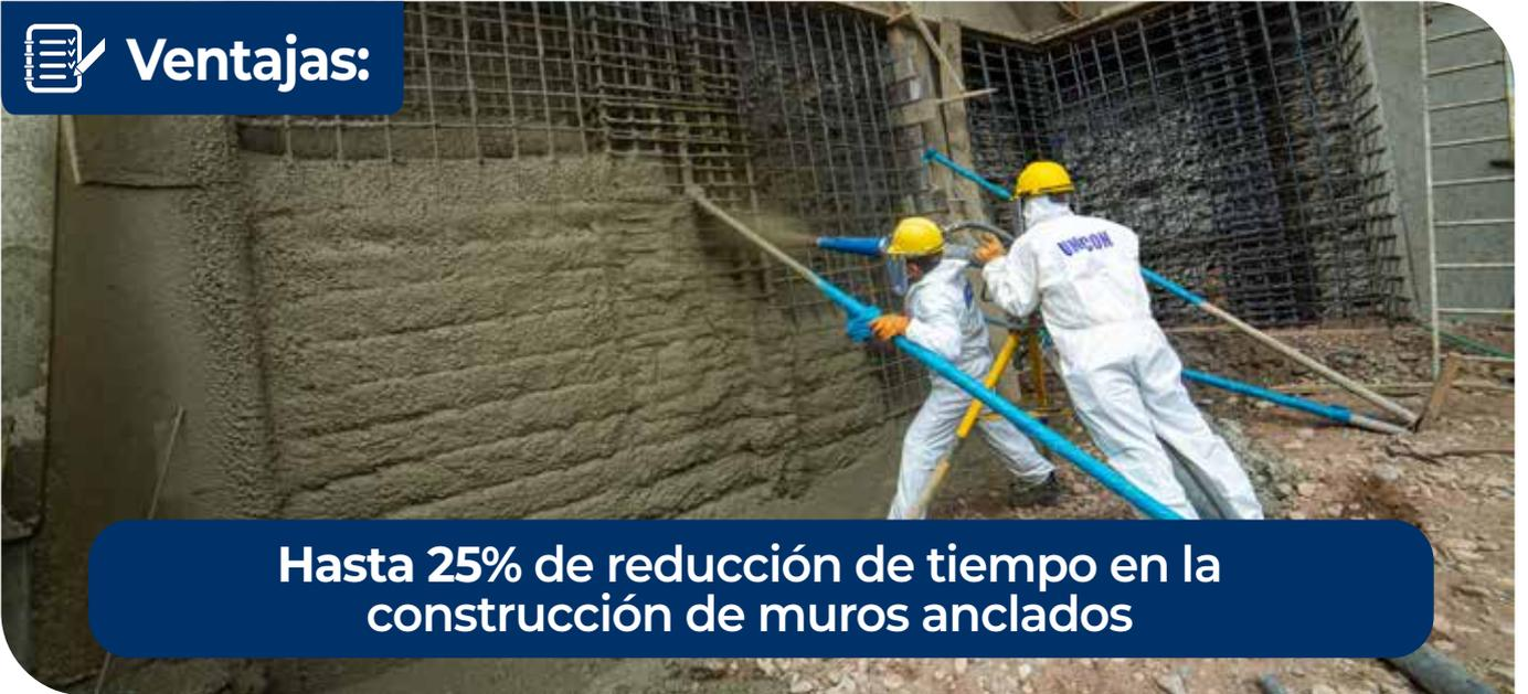
Hasta 25% de reducción de tiempo en la construcción de muros anclados
